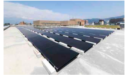
太陽光発電・屋上緑化
